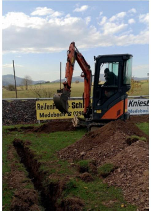
Das heißt mehr Aufwand, mehr Kosten. Außerdem kann der steinige Aushub nicht zum Verfüllen genutzt werden – heißt: mehr Aufwand, mehr Kosten. Dazu mehr auf der nächsten Seite.
